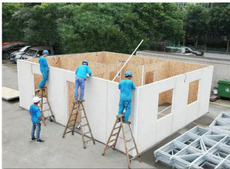
Ce produit est un des modèles de nos Préfabriqués Kit Éco. Tous les composants sont produits par l'automatisation et la normalisation de l'usine. Le processus d'installation nécessite un faible niveau de technologie professionnelle et ne nécessite pas l'assistance d'une machinerie et d'un équipement spécialisé. Les clients peuvent effectuer une installation de bricolage grâce aux dessins d'installation équipés et profiter du plaisir de construire une maison avec leur famille ou leurs amis.
